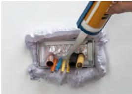
**9.** Danach werden alle Restöffnungen mit einem dauerelastischen Dichtstoff, wie z.B. Silikon, rauchdicht verschlossen. Alternativ zum Silikon kann auch der EasyFoam - Brandschutzmontageschaum verwendet werden.
