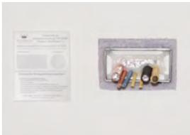
**11.** Nach der Installation wird das ausgefüllte Güteschild neben der Abschottung dauerhaft und gut sichtbar befestigt.
