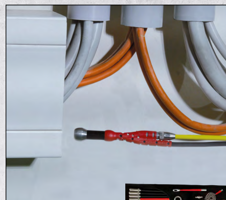
Schächte und Unterflurkanäle
