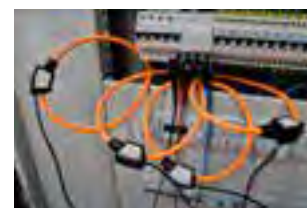
Lieferumfang: inkl. 4 flexiblen Stromwandlern (300 A / 3000 A)
