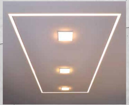
Form und Länge der Lichtlinien legen Sie bei der Planung dieser Lichtlösung bereits in der Rohbauphase fest. Das Licht- und Leuchtendesign kann individuell angepasst und dank der Magnethalter bei Bedarf auch nachträglich verändert werden.
