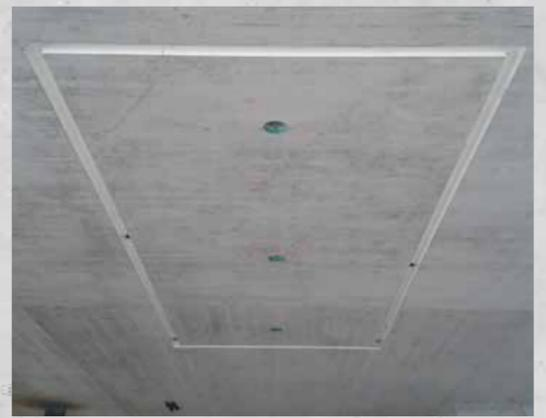
Die mitgelieferten Multiplex-Leisten exakt an den gewünschten Leuchtenintegrationspunkten ausrichten und mit der Schalung fest verschrauben. Anschließend das Betoneinbauprofil PALERMO BE auf die Multiplex-Leiste drücken und mit den im Lieferumfang enthaltenen Schrauben darauf befestigen.
