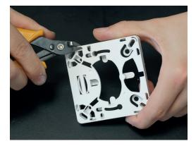
Die Ausbruchstellen an der Unterseite des OAP können z.B. mit einem kleinen Seitenschneider entfernt werden.
