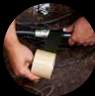
Spleißen und Versiegeln in Außenbereichen
