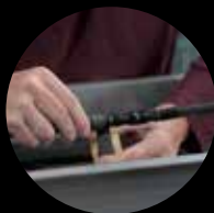
Kabel in Oberleitungsrinnen spleißen
