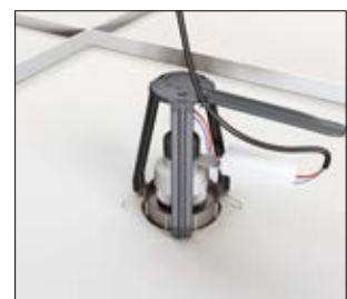
4. Netzteil anschließen und Leitung am Kabelhalter befestigen.
