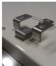
Detail eingehängte Deckenhalter
