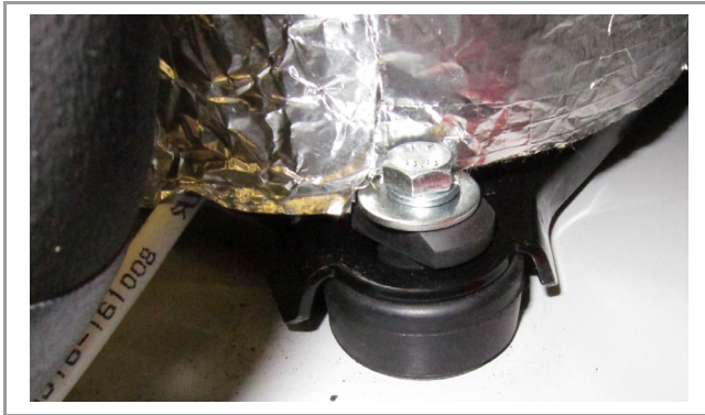
Abb. 3.3:Schwingungsfuß für Verdichter
