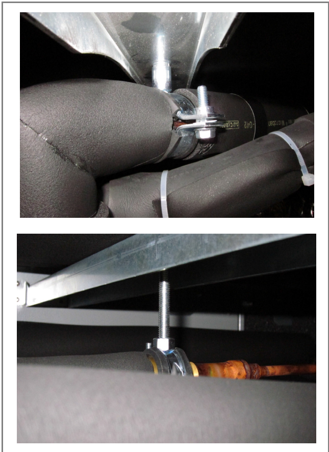
Fig. 3.9: Fixations des tuyaux.
