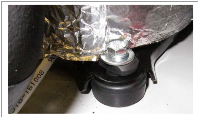
Fig. 3.3:Pied anti-vibrations du compresseur
