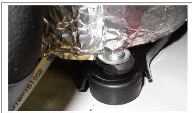
Fig. 3.3: Piedino anti-vibrante del compressore
