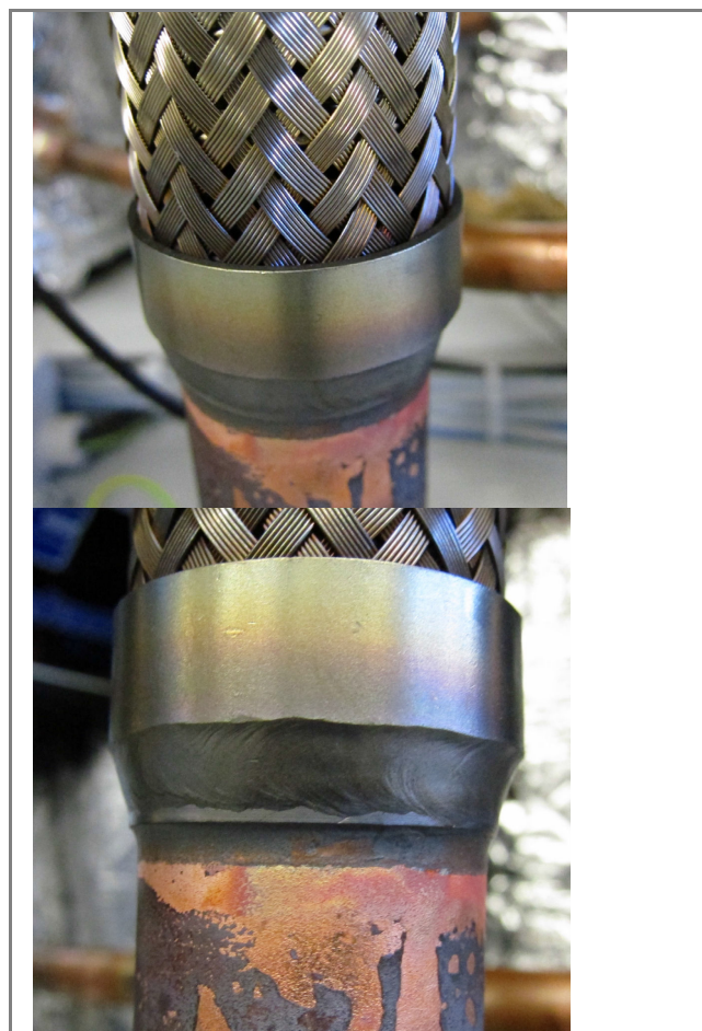
Fig. 3.5: Smorzatore di vibrazioni
