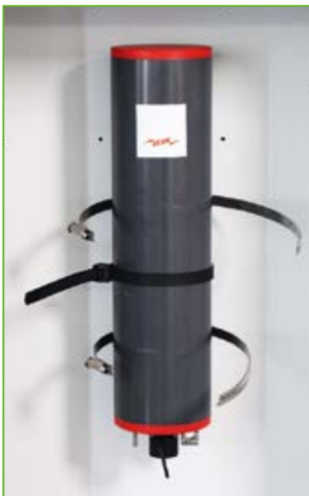
Fig. 4.3 Montage im Verteilerschrank
