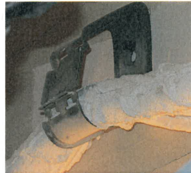
Bild 6: Verformung bei Wandmontage
