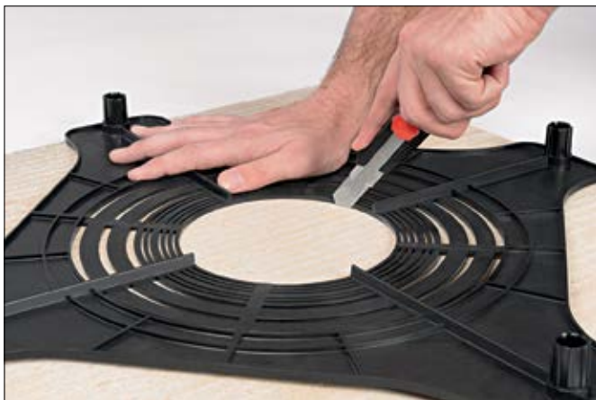
Deckenplatte zusägen.
