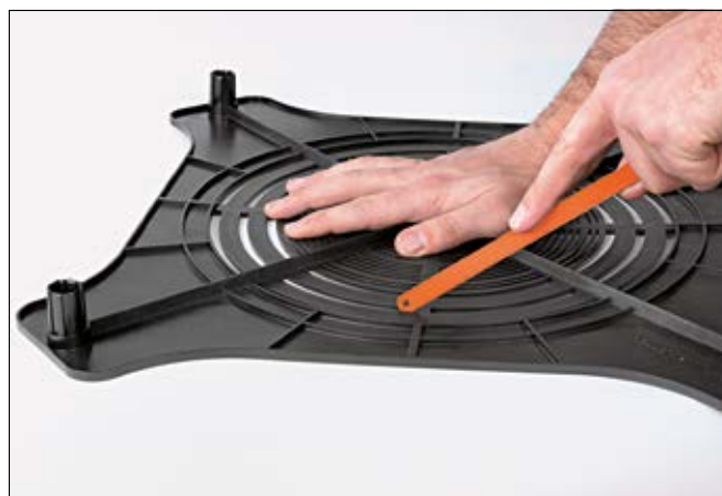
Zusägen der SpotClip-Plate.
