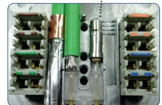
Abb.: Kabel einlegen
