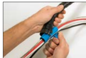
Helawrap auf das Werkzeug aufstecken.
