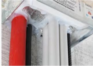
**8.** Abschließend werden an den Stirnseiten Kabelwickel und alle anderen verbleibenden Öffnungen mit handelsüblichen, dauerelastischen Dichtstoffen wie Silikon oder Acryl verschlossen.
