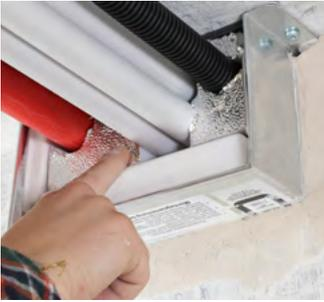
**7.** Schaumstopfen der Kabelbelegung entsprechend ausschneiden und an den Stirnseiten der Kabelbox die Restöffnungen verschließen. Wahlweise kann auch nur von einer Seite ein Schaumstopfen angebracht werden, wenn der Innenraum der Kabelbox in voller Tiefe mit > 1000 °C hitzebeständiger Mineralwolle verstopft wird. Eine weitere Alternative ist das Verschließen mit 3 Schaumstopfen hintereinander.
