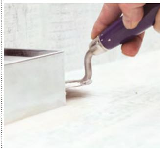
6. Die Kabelbox wird danach in der Bauteilöffnung vermörtelt oder einbetoniert. Je nach Öffnungsgröße kann dazu ein Schal Brett zu Hilfe genommen werden.
