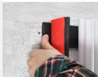
4. Die mitgelieferten Grafitstreifen auf beiden Seiten mittig waagerecht zwischen den gebohrten Löchern, soweit vorhanden hinter den schon verlegten Kabeln direkt an die Wand kleben.
