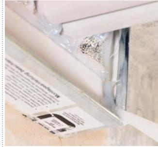
**8.** Abschließend werden an den Stirnseiten Kabelzwicke und alle anderen verbleibenden Öffnungen mit handelsüblichen, dauerelastischen Dichtstoffen wie Silikon oder Acryl verschlossen.
