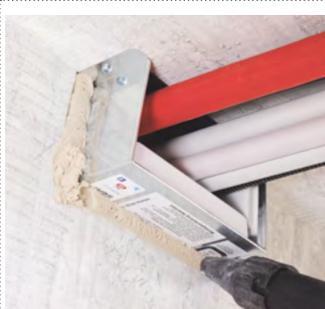
6. Die Kabelbox wird danach in der Bauteilöffnung in voller Wandtiefe vermörtelt oder eingegipst.
