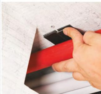
4. Die mitgelieferten Graphitstreifen auf beiden Seiten mittig quer zur Kabelführung zwischen den gebohrten Löchern, soweit vorhanden hinter den schon verlegten Kabeln direkt unter die Decke kleben.
