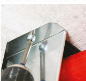
5. Bei bereits vorhandener Kabelbelegung wird die Kabelbox über die Kabel in die Bauteilöffnung geschoben und an den seitlichen Montagelaschen mit den Dübeln in der Decke verschraubt. Alternativ können auch Schlagdübel verwendet werden.
