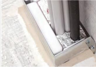
**7.** Schaumstopfen der Kabelbelegung entsprechend ausschneiden und an den Stirnseiten der Kabelbox die Restöffnungen verschließen. Wahlweise kann auch nur von einer Seite ein Schaumstopfen angebracht werden, wenn der Innenraum der Kabelbox in voller Tiefe mit > 1000 °C hitzebeständiger Mineralwolle verstopft wird. Eine weitere Alternative ist das Verschließen mit 3 Schaumstopfen hintereinander.
