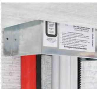
5. Bei bereits vorhandener Kabelbelegung wird die Kabelbox über die Kabel in die Bauteilöffnung geschoben und an den seitlichen Montagelaschen mit den Dübeln in der Wand verschraubt. Alternativ können auch Schlagdübel verwendet werden.
