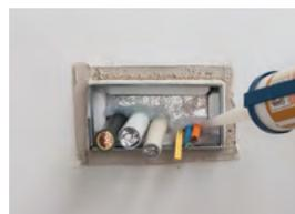
8. Danach werden alle Restöffnungen mit einem dauerelastischen Dichtstoff, wie z.B. Silikon, rauchdicht verschlossen.
