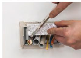
6. Nach der Kabelinstallation werden die EasyFoam-Stopfen einige mm größer als benötigt zugeschnitten, damit sie hinterher fest in der Öffnung sitzen.
