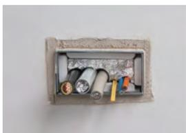
7. Der Stopfen wird mit der Restfolie nach außen in die Restöffnung eingesetzt. Reste können z.B. zur Abdichtung von Leerrohren genutzt werden.
