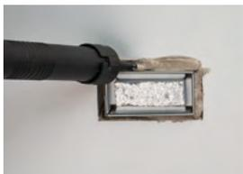
3. Vollständig in Wandtiefe eingipsen. Das Eingipsen mit Hilfe einer Mörtelspritze geht wesentlich schneller und einfacher.
