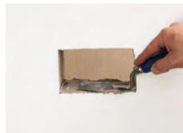
2. Gipsbett in die Öffnung einbringen (in Trockenbauwänden zusätzlich eine Laibung in die Öffnung einbringen).
