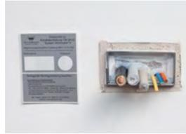
**10.** Nach der Installation wird das ausgefüllte Güteschild neben der Abschottung dauerhaft und gut sichtbar befestigt.
