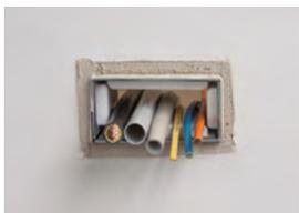
5. Es folgt die Kabelverlegung. Der Innenraum kann zu 100% genutzt werden. Bei großen Kabelmengen ggf. vorher schon Zwickel abdichten.
