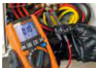
Durchgangsprüfung von Schutzleitern.
