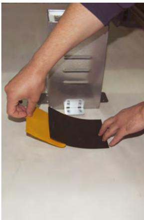
3. Die Dichtungsmatte wird .dort auf die Deckenschalung geklebt, wo die Aussparung und spätere Abschottung in der Decke geplant ist.
