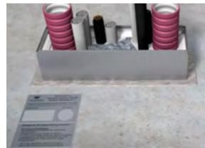
8. Nach der Installation wird das ausgefüllte Güteschild neben der Abschottung dauerhaft und gut sichtbar befestigt.
